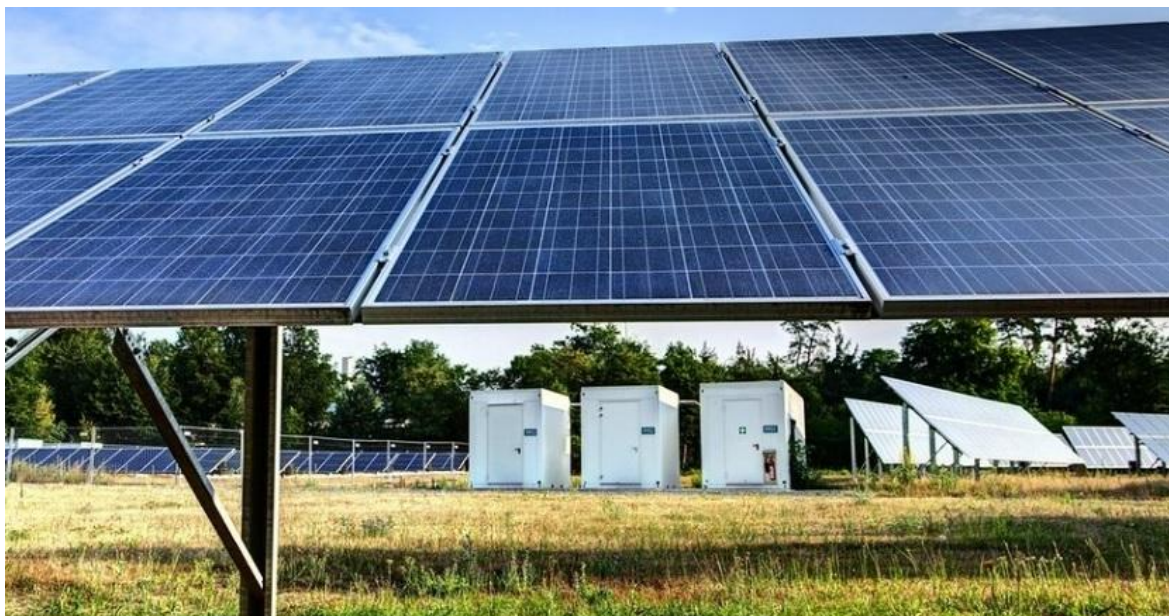
圖 22 光電配置儲能系統 66
