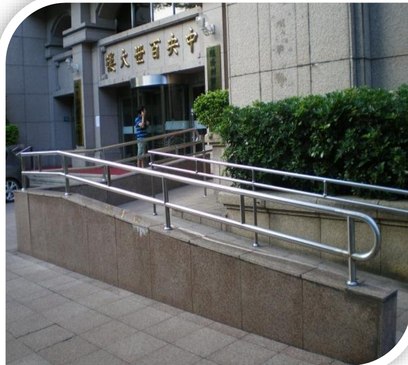
大門口外無障礙斜坡道
